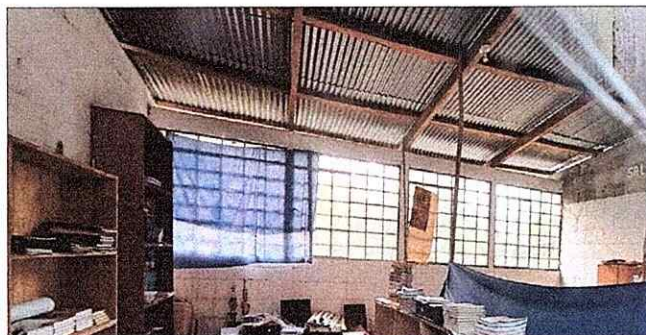
Foto 5: SUSTITUCION DE ESTRUCTURA DE TECHO DE LA DIRECCION.
