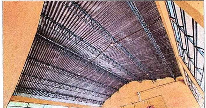
Foto 2: MANTENIMIENTO Y SUSTITUCION DE ESTRUCTURA DE TECHO.
